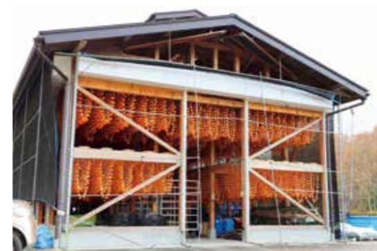
柿ばせ。住宅一棟をまるごと改築した大きな建物の屋根の下に干し、長時間熟成させます
